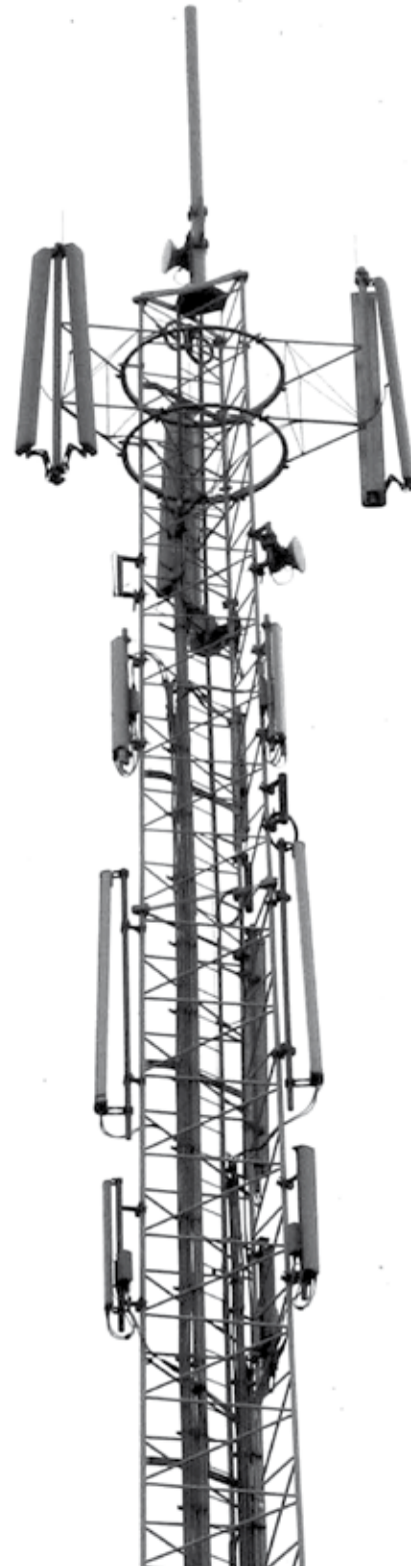
Zal de Haagse zendmast er in de toekomst net zo uit komen te zien als dit exemplaar? (bron: www.stralingsarm-nederland.org )
