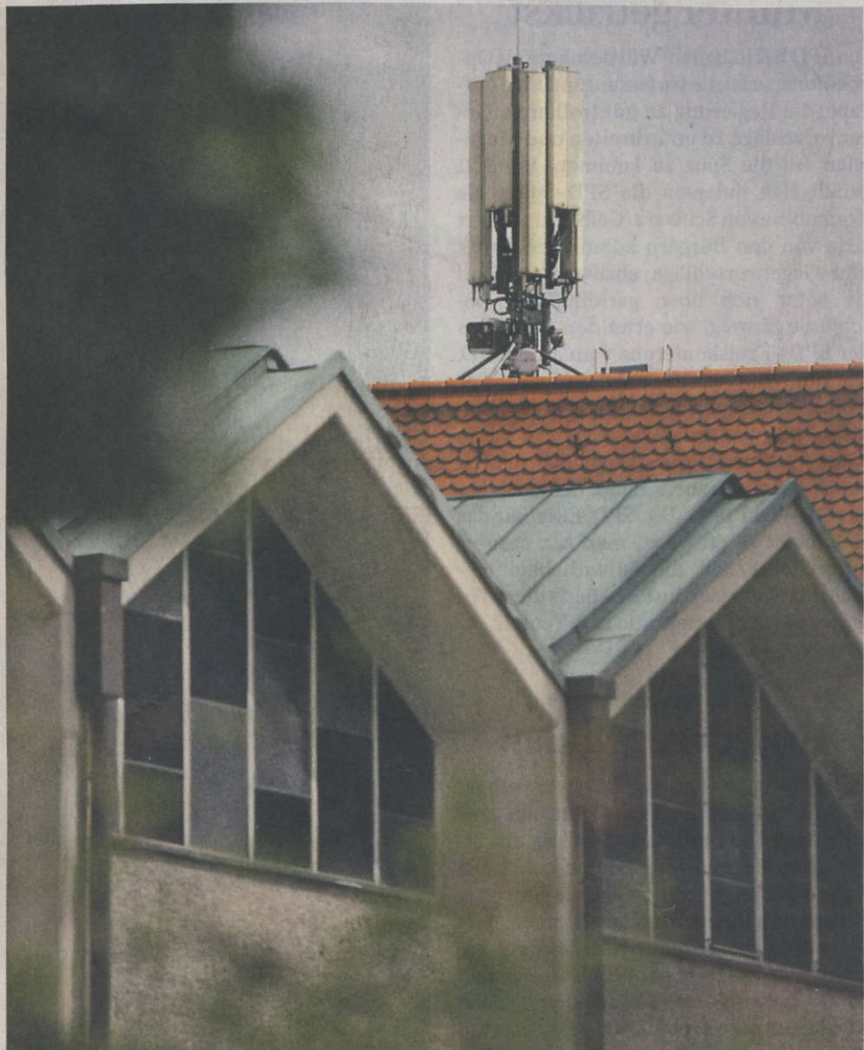
Dieser Mobilfunkmast steht auf dem Gebäude Bismarckstraße 57 gegenüber der Pauluskirche. Dort ist die evangelische Haus- und Familienpflege untergebracht. Foto: Michael Steinert
